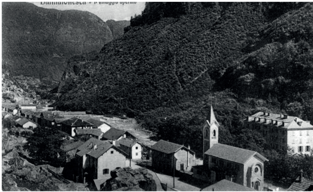
Das Arbeiterdorf Balmalonesca bei Varzo während des Baus des Simplontunnels. Heute sind davon nur noch Ruinen übrig.
